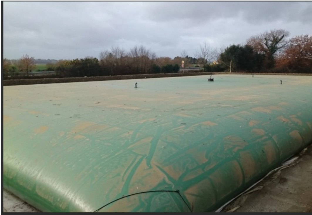
Figure 4: exemple de poche souple de 1000 m 3
