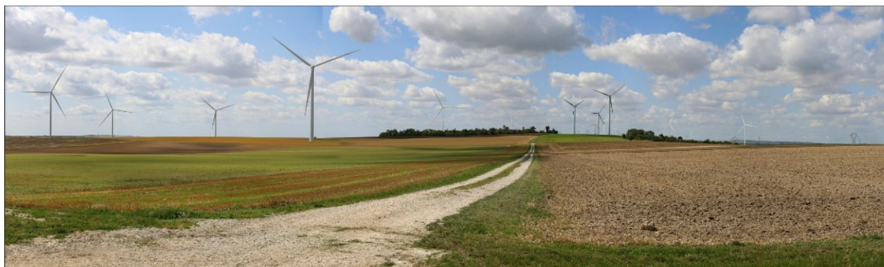
Figure 4: Une vue partielle des éoliennes projetées depuis le chemin agricole de la Côte de Braux. Toute émergence d'éoliennes est prégnante sur un secteur en openfield
