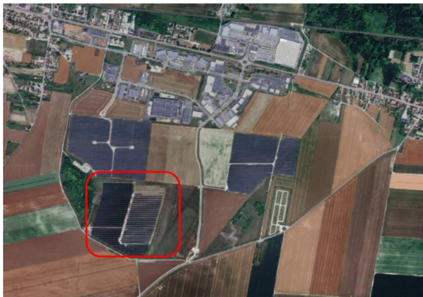
Figure 1: localisation des centrales photovoltaïques au sein du parc Aéromia (tracé rouge : centrale Sonnedix)
