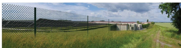
Simulation des effets résiduels. Les locaux techniques (hors les PTR) seront peints de manière similaire aux bâtiments d'élevage (toit ocre, mur beige).
