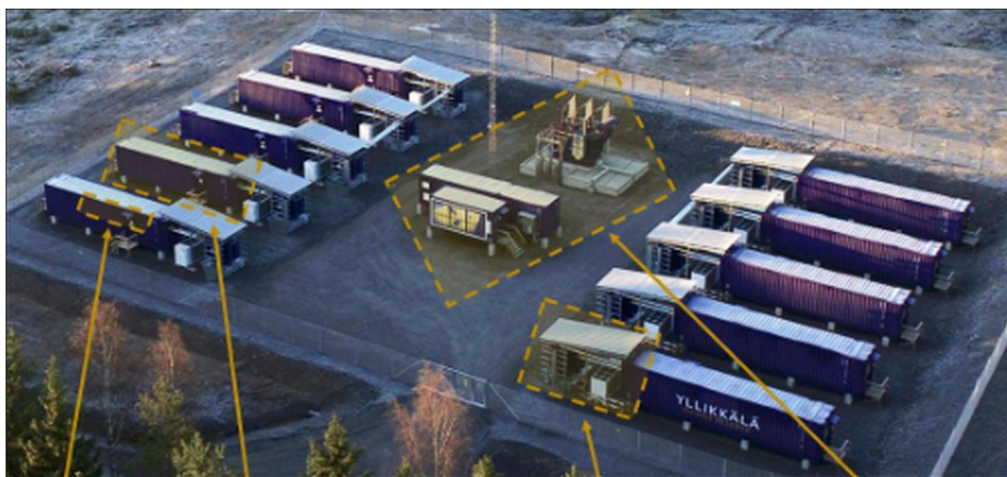
Exemple d'unité de stockage d'électricité par batteries (Source : page 35 du fichier informatique étude d'impact T2/P1)
