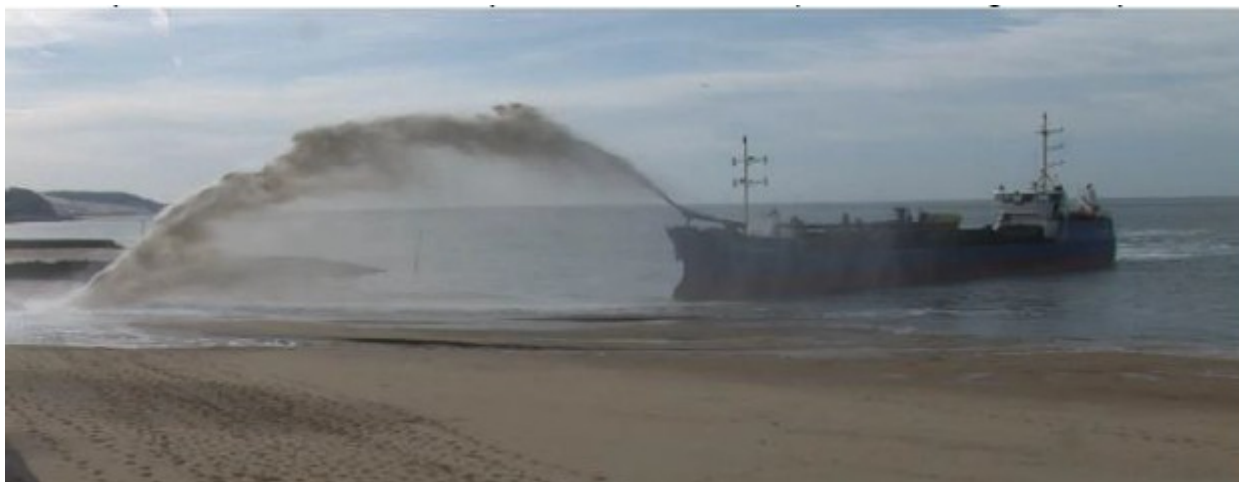
Exemple d'opération de ré-ensablement par refoulement direct – Pièce annexe – Rapport FR22016 RA2 p. 43
