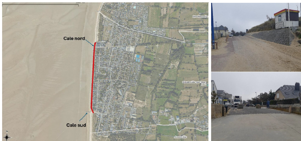
Fig. 5 : Localisation de la fermeture des cales nord et sud et vues des deux cales (p. 27 et 28 de l'EI)
