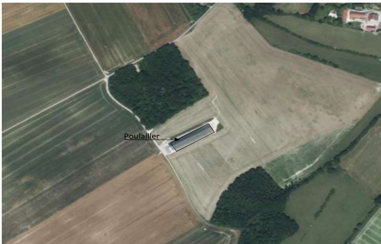
Figure 2 : Une vue aérienne de l'installation
