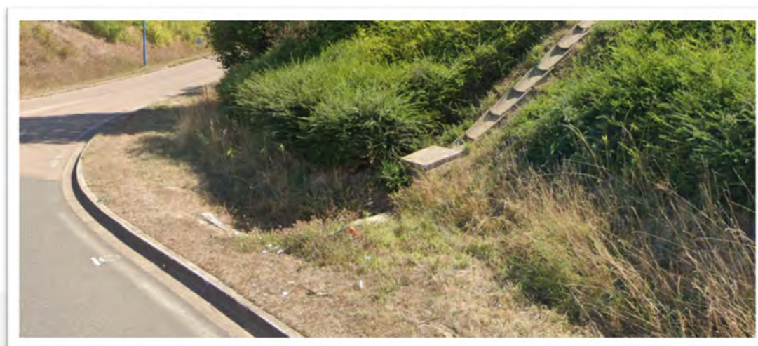
Figure 7 : Photographie du fossé – Zone Nord de la ZAE – RN 151
